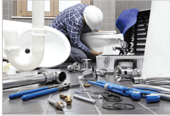
Görsel 3.44: Sıhhi tesisatta çalışma
