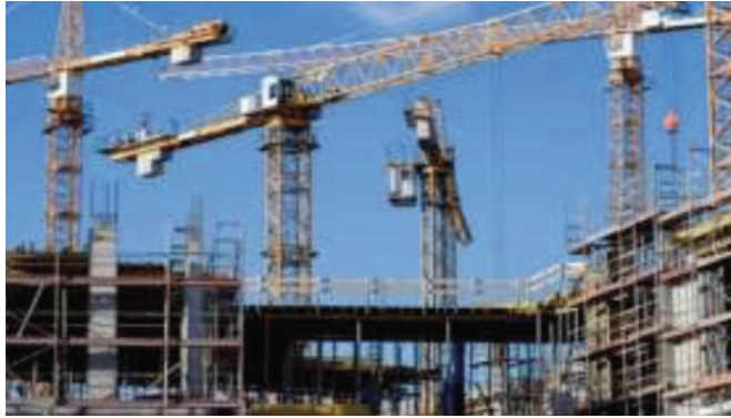
Görsel 3.34: Kaldırma aracı-kule vinç
